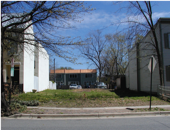
View of 219 N. West St. from N. West St.
